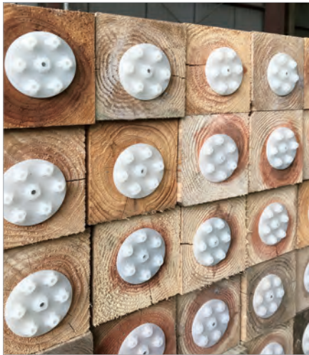
釘打ちの管理状況
